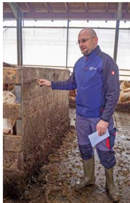
Damit die Ventilation in den Liegeboxen ankommt, müssen unnötige Hindernisse entfernt werden. Beispielsweise sollen die durchgehenden Holzabtrennungen der Randliegeboxen im oberen Bereich durch Rohre ersetzt werden.
